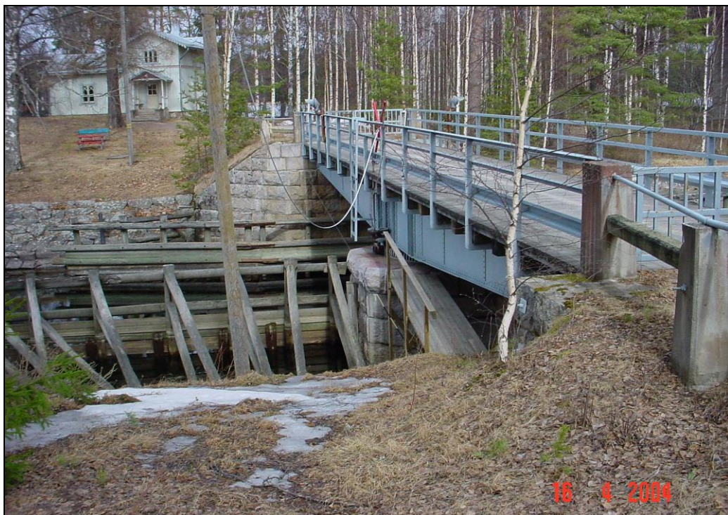
Kautun kanavan vanhan sillan paikka kuvattuna etelärannalta pohjoiseen.
